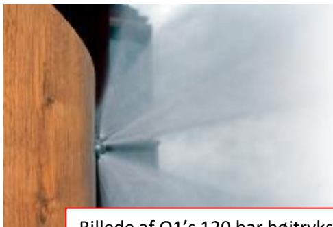
Billede af Q1's 120 bar højtryks Vandtågesystem i funktion
